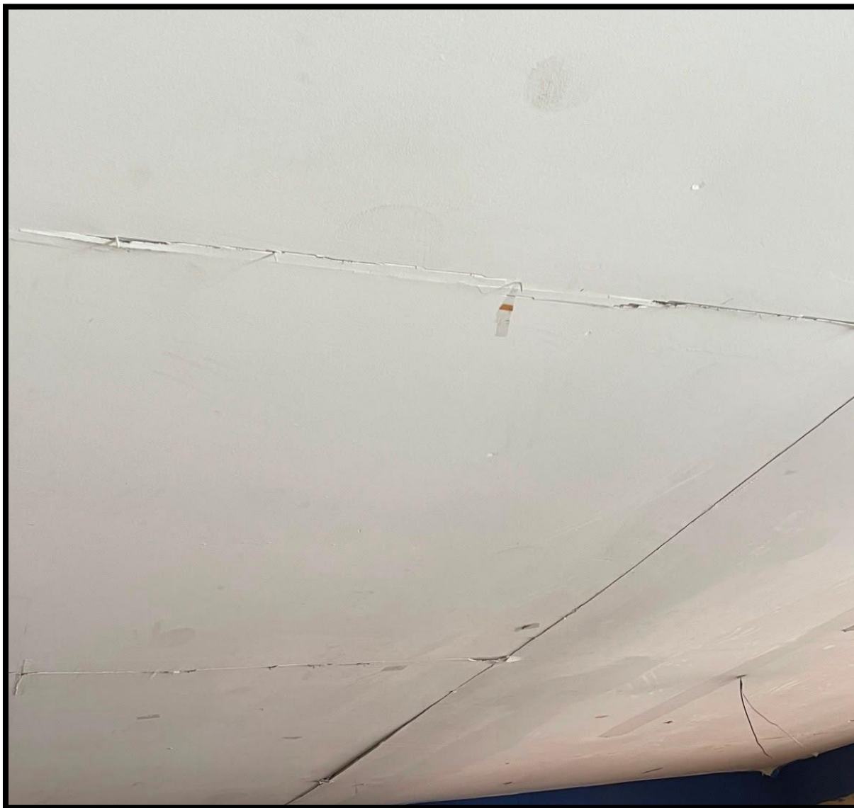
Fotografía 4. Desprendimiento y dilatación en uniones de las láminas de panel yeso en cielo falso.
