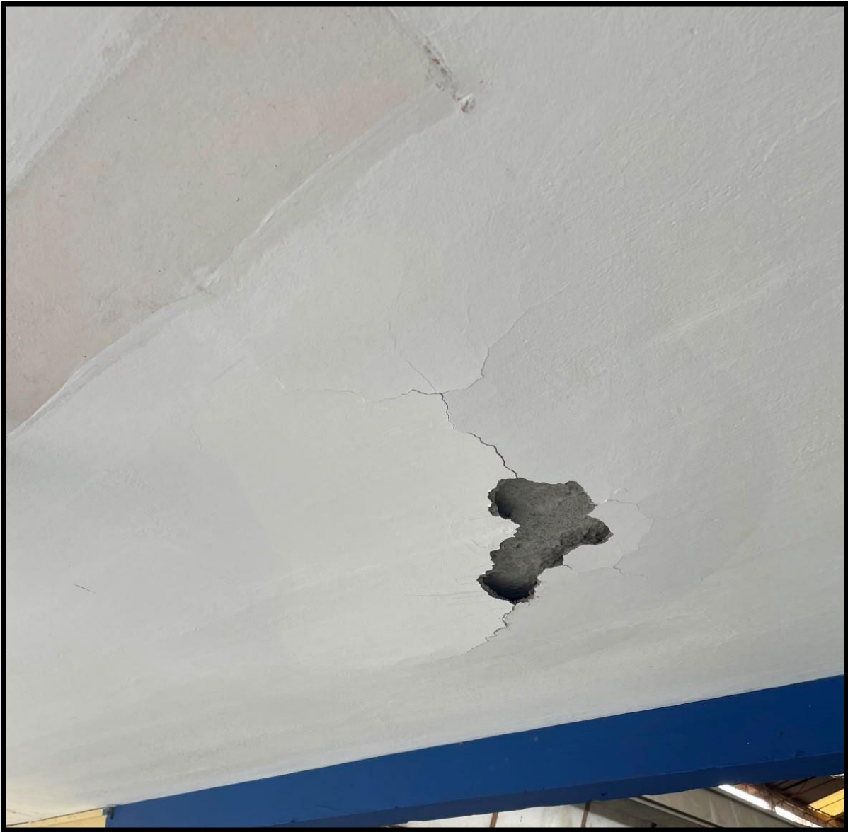
Fotografía 3. Desprendimiento de materiales de acabado (Repello y Estuco).
