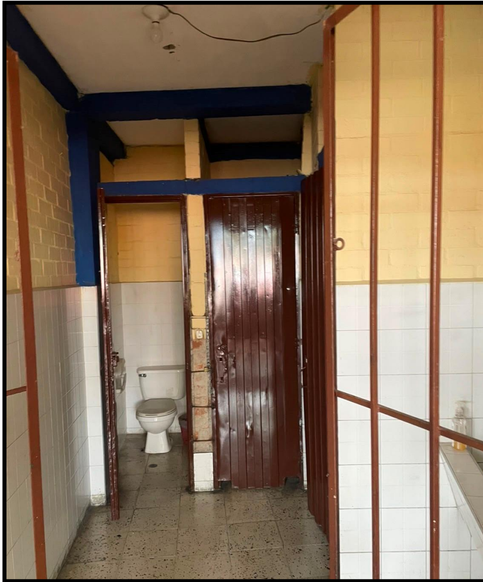
Fotografía 3. Baños sin afectaciones.
